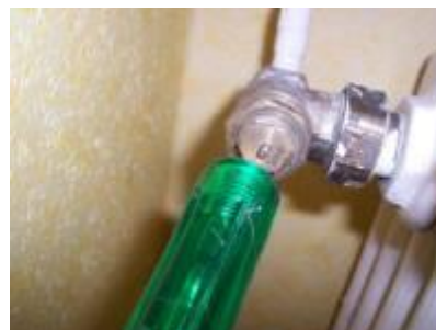
Mit einem Schraubendreher klopfen
