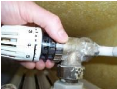
Überwurfmutter lösen
