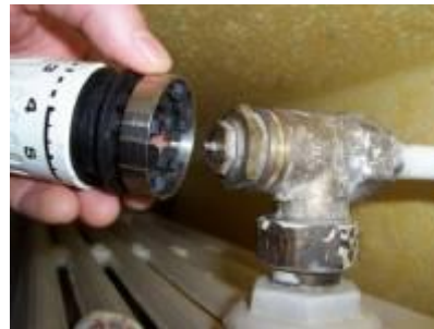
Thermostatkopf abnehmen
